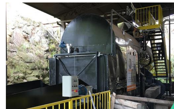
Instalações finais e acompanhamento
